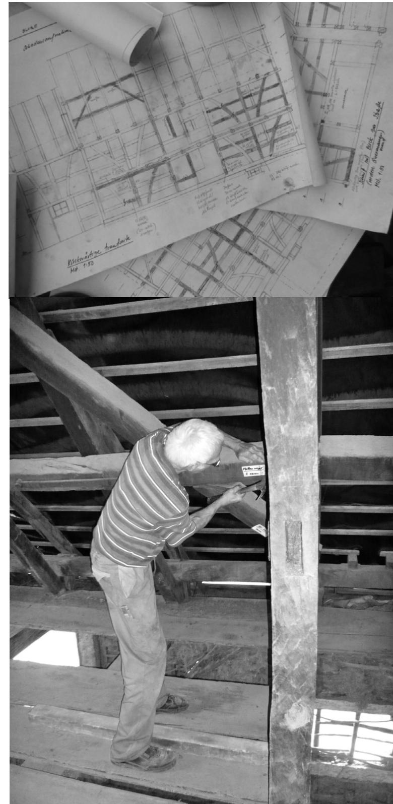
Deckenverkleidungen, die Wandtäfelung der kalten Stube, Bodenbretter, Treppen und Türen werden zurzeit für den Wiederverbau vorbereitet.
