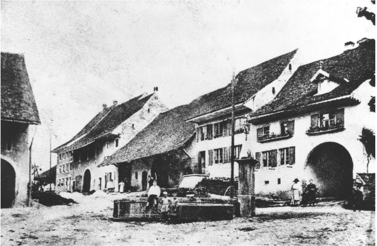
Abb. 8. Wenslingen BL, Dorfplatz um 1900. Unterschiedliche Firsthöhen widerspiegeln den Ablauf des Aufbaus in Stein. Foto Denkmalpflege BL.
