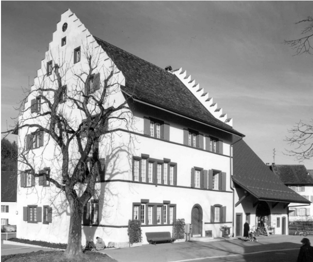
Abb. 5. Bubendorf BL, «Dinghof». Neubau 1600i nach Niederbrand des Vorgänger-Verwaltungsgebäudes. Foto Denkmalpflege BL.
